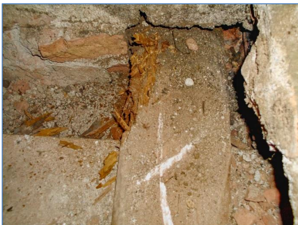
Obr.č. 9 – SONDA S4 biotická destrukce zhlaví ST INDEX D
