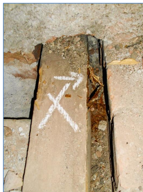
Obr.č. 12 – SONDA S6 biotická destrukce zhlaví ST INDEX D
